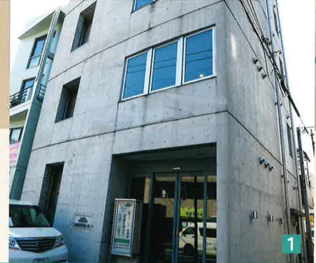
1 八広駅前に式場を構え地域のランドマークともなっている
